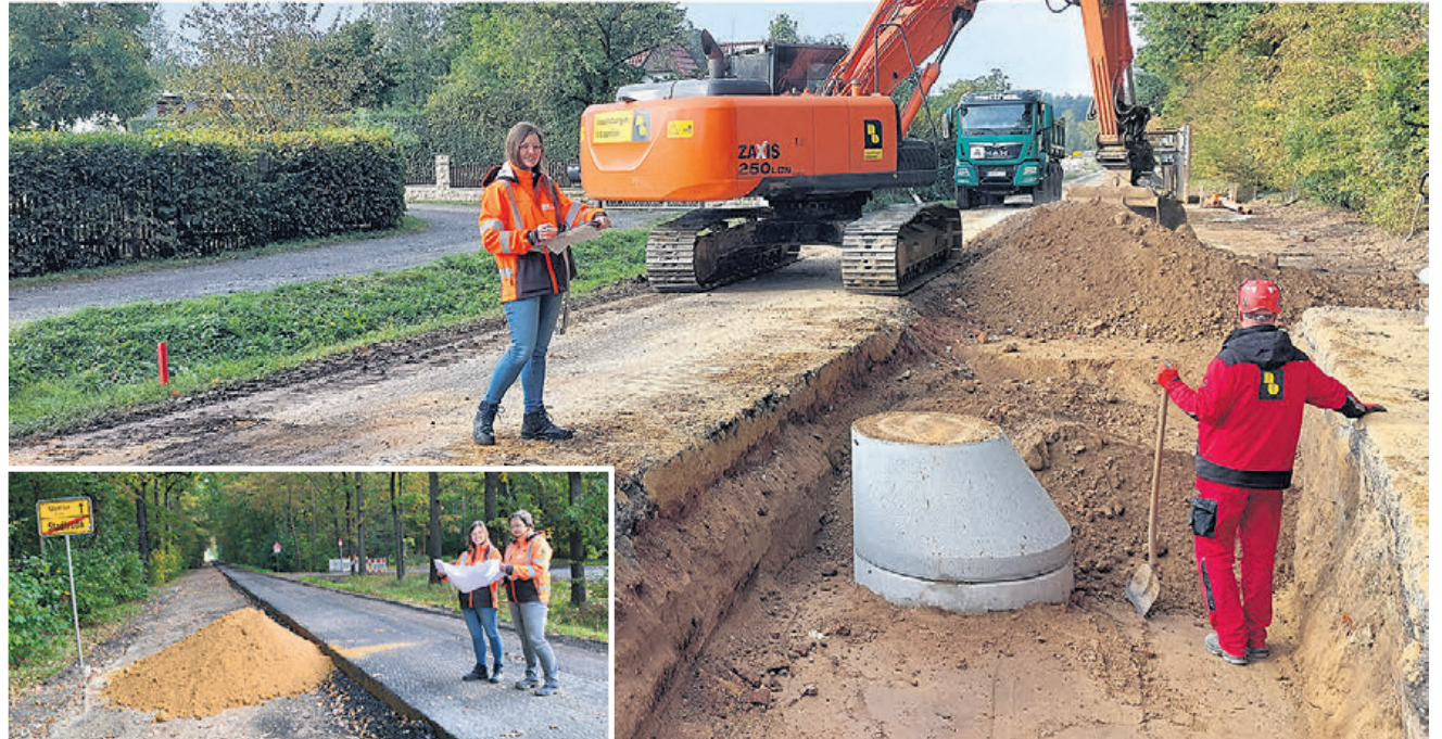
Während Mitarbeiter der Naumberger Bauunion den Rohrgraben in der Landesstraße in Quirla befüllen, besichtigte Projektingenieurin Sophie Höltge das Baugeschehen. Kleines Foto: Sophie Höltge (li), Projektingenieurin, und Susanne Taubig (re), Leiterin Investitionen des ZWA „Thüringer Holzland“, bei der Begehung der Baustelle im Bereich Stadtroda.
