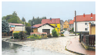
Die Baumaßnahmen für den zentralen Anschluss an die Kläranlage Hermsdorf werden im unteren Ortsteil bis zum „Platz der Deutschen Einheit“ 2024 beendet.
