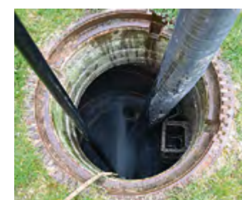
Regelmäßige Kanalreinigungen verhindern Verstopfungen.
